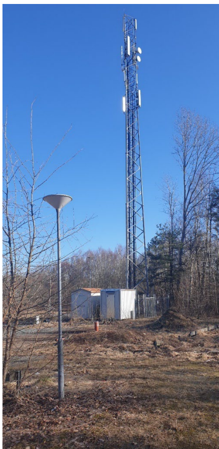
Befintlig mast med tillhörande teknikbodar som föreslås flyttas från planområdet. Foto: Kristianstad kommun.
